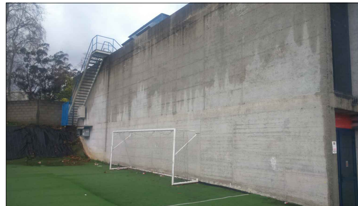
vista interior de fachada de actuacion
